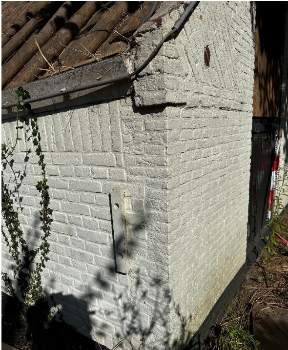
3.25 De hoek van de linker zijgevel met de voorgevel
