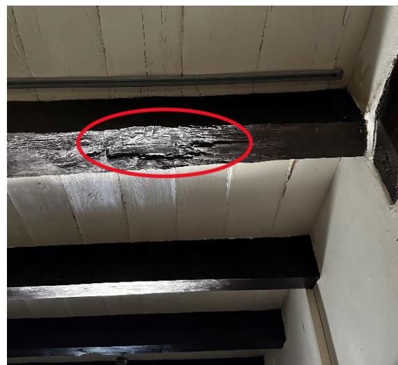
3.22 Gebint in het woongedeelte, de oorspronkelijke aansluiting van het korbeel is nog zichtbaar
