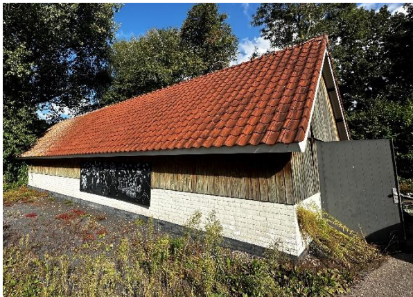
3.35 Voor- en zijgevel van de schuur
