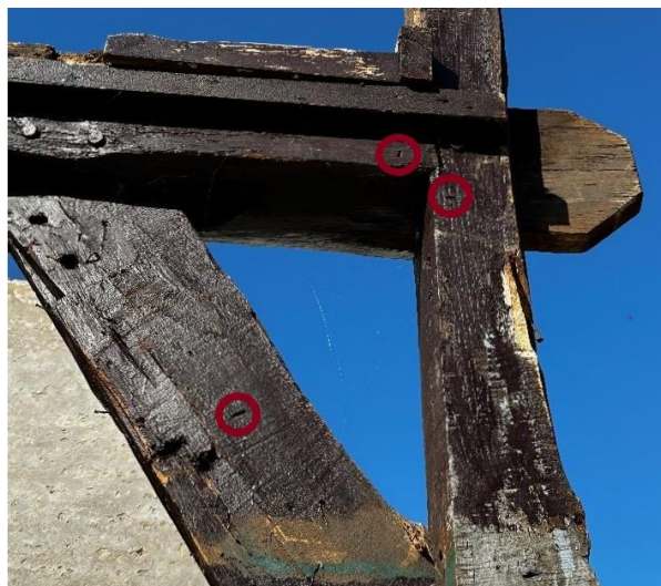
3.21 De telmerken in de stijl, dekbalk en het korbeel van de rechterzijde van het gebint
