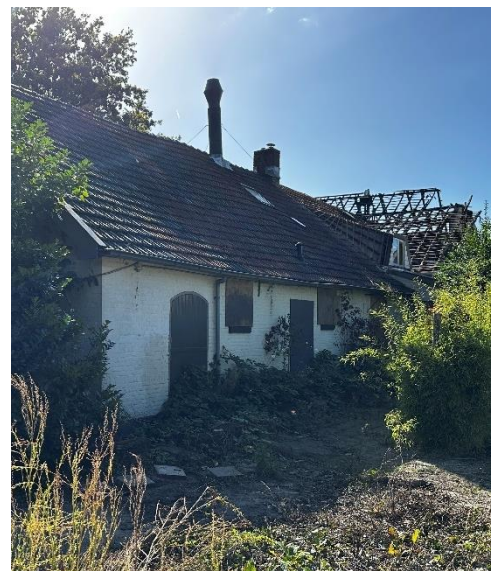
3.32 De noordelijke (achter)gevel van de uitbouw
