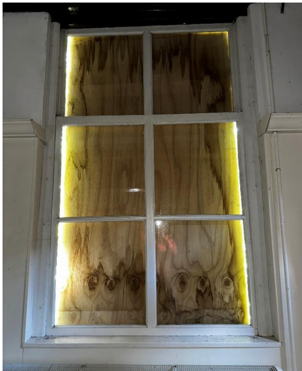
3.27 Schuifvenster gezien vanuit de binnenzijde
