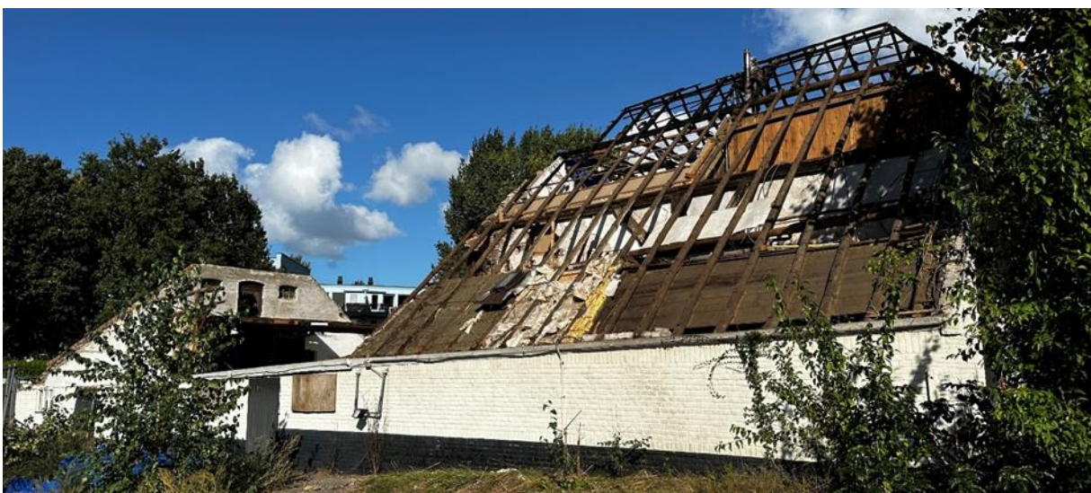
3.19 De linkerzijgevel van de boerderij; boven het woongedeelte is de dakconstructie nog aanwezig
