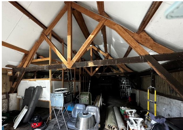
3.36 Binnenzijde van de schuur met de nog oorspronkelijke spanten.
