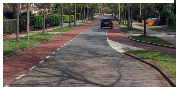
Overgang fietspad naar fietsstrook met rugdekking
